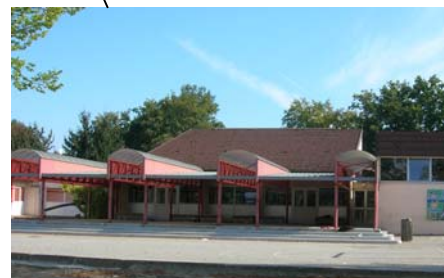
Ecole Intercommunale Elémentaire
